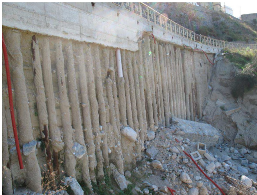
fig. 11-12: dilavamento del rilevato stradale e conseguente messa a giorno della paratia
