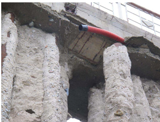
fig. 13-14: cedimento cordolo e rottura di tre micropali della paratia
