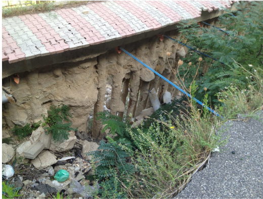
fig. 9-10: svuotamento del rilevato stradale tra il vecchio muro e la paratia di micropali
