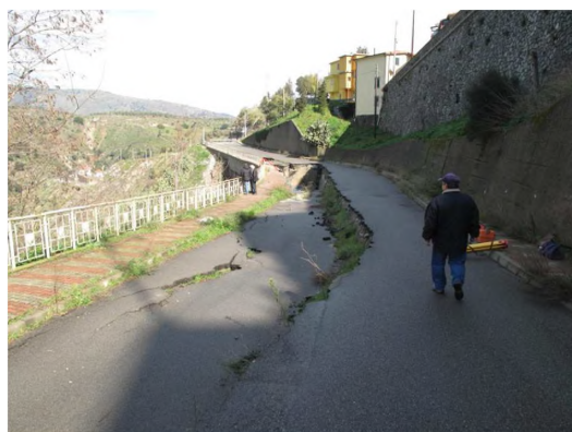
fig. 3-4: vistoso cedimento della sede stradale per un tratto di circa 55m
