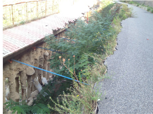
fig. 9-10: svuotamento del rilevato stradale tra il vecchio muro e la paratia di micropali
