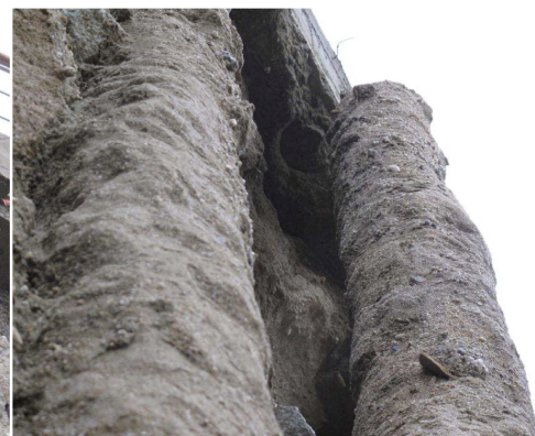
fig. 13-14: cedimento cordolo e rottura di tre micropali della paratia
