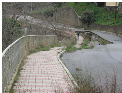
fig. 3-4: vistoso cedimento della sede stradale per un tratto di circa 55m
