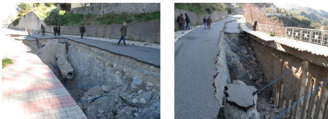
fig. 7-8: svuotamento del rilevato stradale-messa a giorno di un originario muro di sostegno
