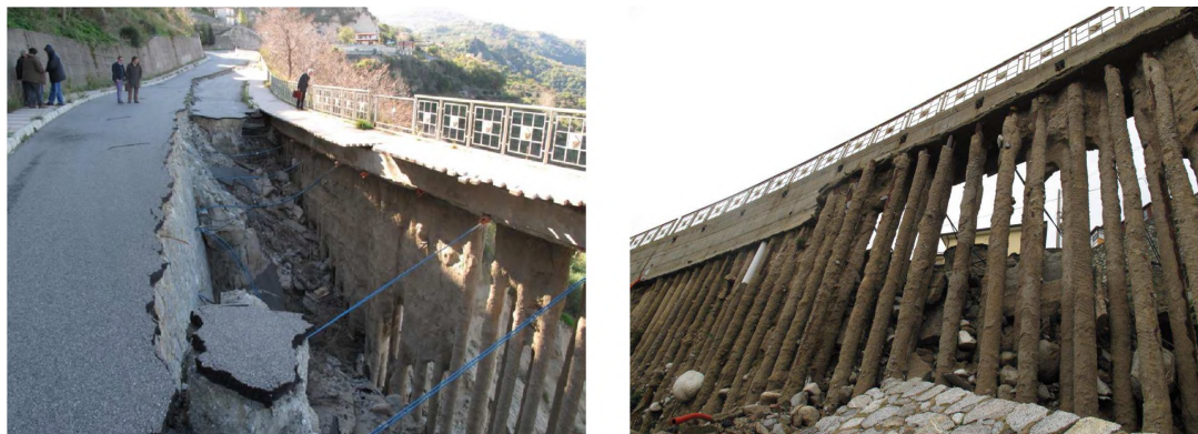
fig. 5-6: svuotamento del rilevato stradale per un tratto di circa 40 m
