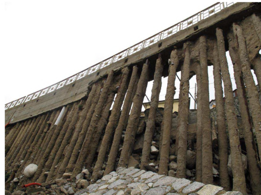
fig. 11-12: dilavamento del rilevato stradale e conseguente messa a giorno della paratia
